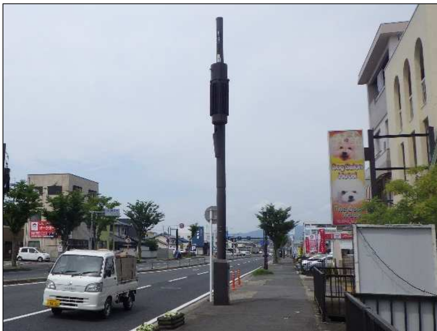
図 5.2 柱状型機器の整備事例 (奈良市 二条大路南四丁目地内)
