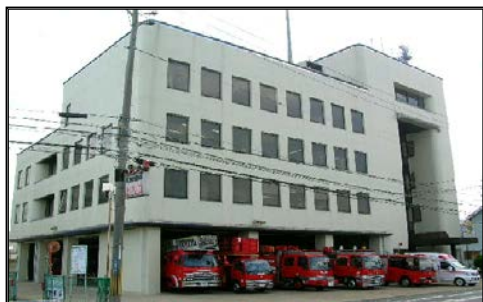
消防局・南消防署併設庁舎
