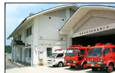
東消防署東部分署
