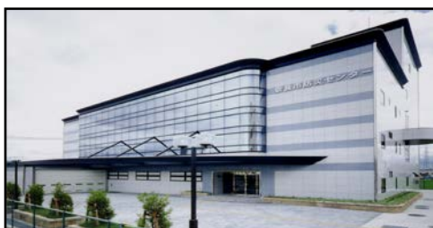
防災センター
