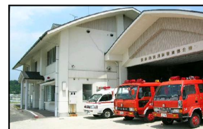
東消防署東部分署
