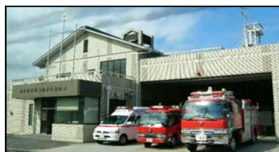
中央消防署南部分署
