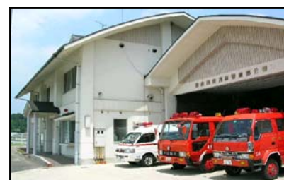
東消防署東部分署
