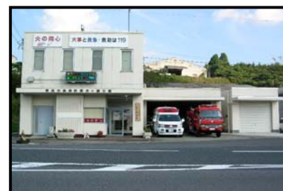
東消防署月ヶ瀬分署
