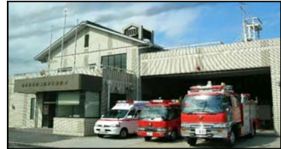
中央消防署南部分署
