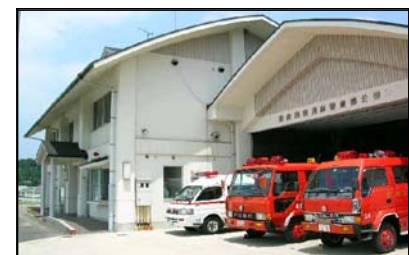
東消防署東部分署
