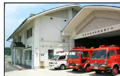
東消防署東部分署
