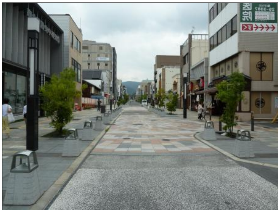
図 3.2 無電柱化整備事例（三条通）
