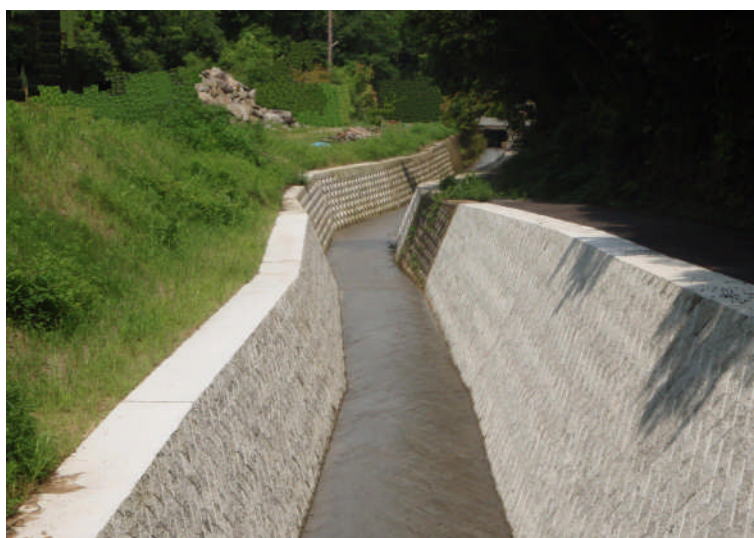
改修された普通河川
