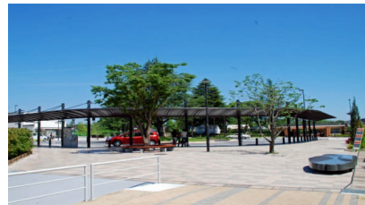
近鉄菖蒲池駅北口駅前広場
