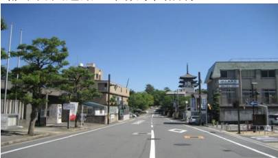
電線共同溝 (鶴福院町東寺林町周辺)
