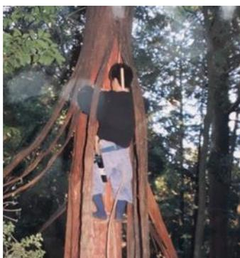
さて、桧皮葺の話に戻ります。桧皮葺に使う桧の皮は樹齢100年以上の大きな桧の立ち木から採取します。100年以上経った木でないと、木が枯れてしまうのだそうです。皮をめくると人を原皮師（もとかわし）と呼びますが、皮を採取する時には、その下の中の皮に傷をつけないよう、慎重に作業が進められます。また、桧の皮を屋根に留めるためには竹釘を使いますが、この竹釘を作る人を竹釘師と呼びます。竹釘はそげが出ないように火であぶって表面を滑らかにします。桧皮の葺き替えでは22万本もの竹釘を使うそうですが、現在、竹釘を生産しているのは国内で一事業所だけのようです。そして、屋根を葺く、葺師がいます。昔から脈々と受け継がれてきたこうした技術によって、桧皮葺は支えているのです。3つのうちどれか1つが欠ける
