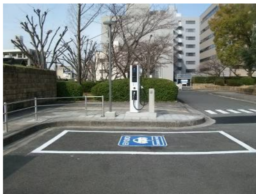
でんき じどうしゃようきゅうそくじゅうでんせつび しやくしょ 電気自動車用急速充電設備（市役所）
