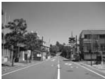
電線共同溝（鶴福院町）
