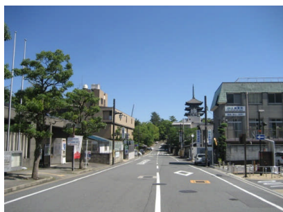
電線共同溝 (鶴福院町)
