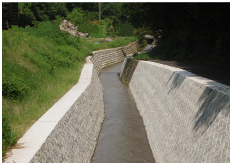
改修された普通河川
