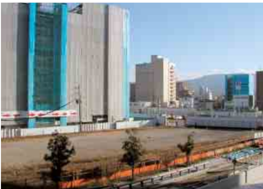
JR奈良駅西側の保健所等複合施設建設予定地
