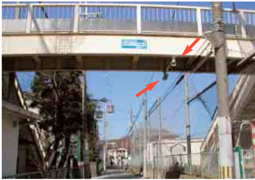
通学路に設置された防犯カメラ(富雄北一丁目)
