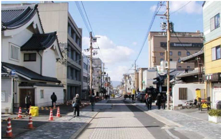
拡幅が進む三条通り（やすらぎの道から西側部分）
