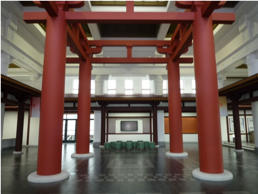
内部（第一次大極殿正殿の柱と組み物）
