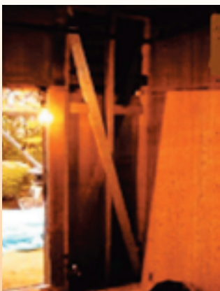
新たに筋かいを設置しました。
