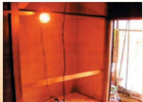
既存壁を外し、構造用合板にて補強しました。
