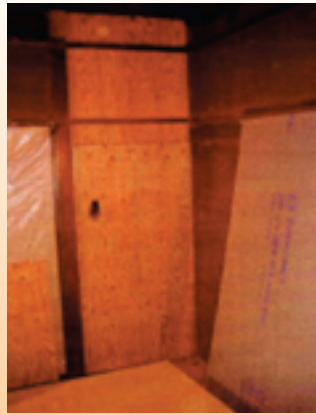
既存壁を外し、構造用合板にて補強しました。
