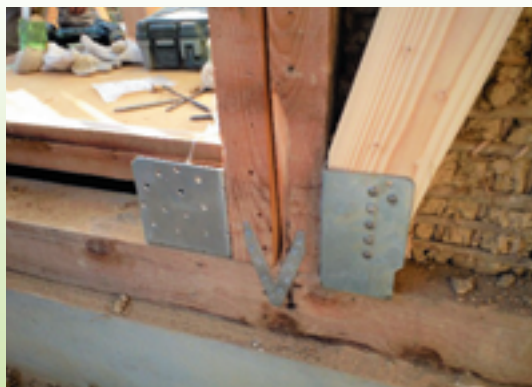
柱と土台の接合が不十分であったため、新たに金物を取り付けました。
