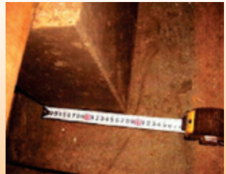
基礎を新たに増設し、耐力壁を設置しました。
