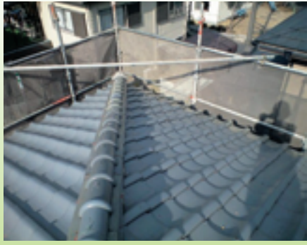
(工事前) 土葺き瓦を撤去
