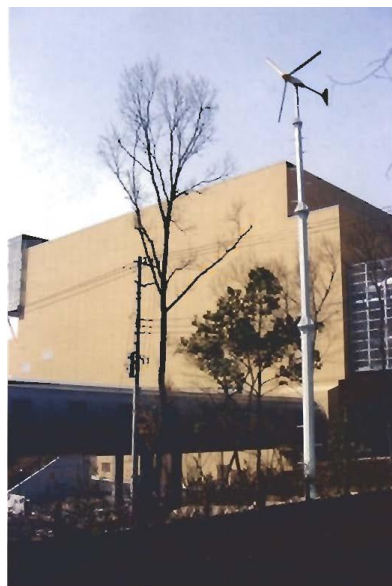
渡り廊下・風力発電
