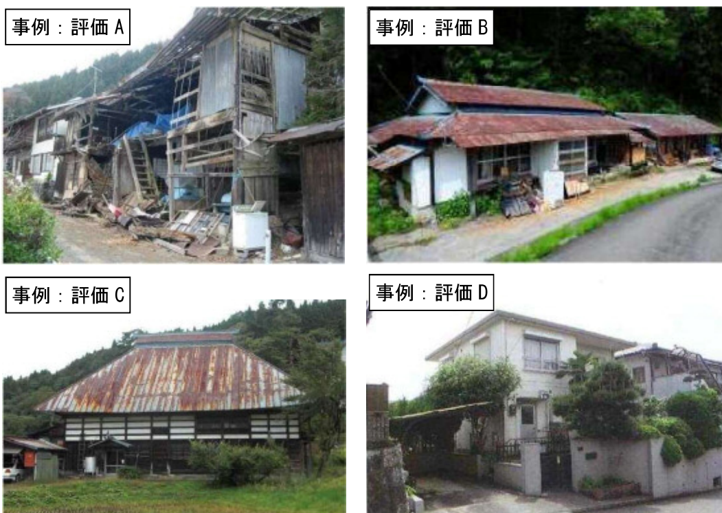
図 2. 4 空き家等判定事例
