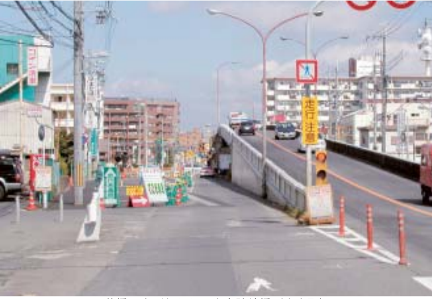
落橋工事が行われる奈良跨線橋 (大森町)
