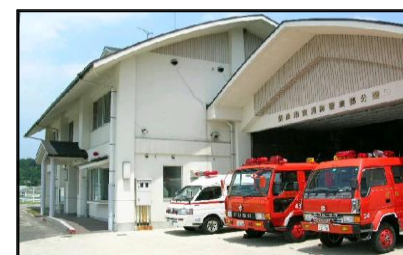
東消防署東部分署
