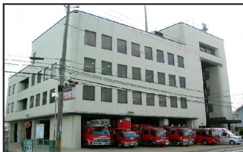
消防局・南消防署併設庁舎
