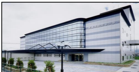
防災センター
