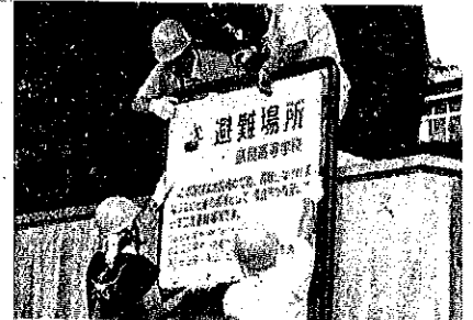
避難所の指定標識の取外し作業
