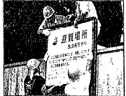
避難所の指定標識の取外し作業 8月 県立奈良高等学校正門前
