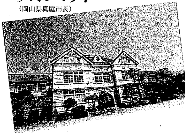
旧遷荷小学校校舎
