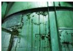
塗装が傷み、錆が流れる焼却炉
