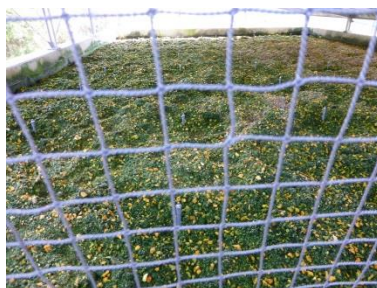
屋上部分のロックウール脱臭
