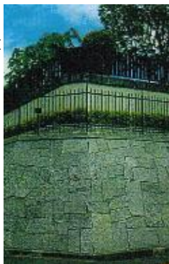
カーブミラー新設工事 【設置前】
