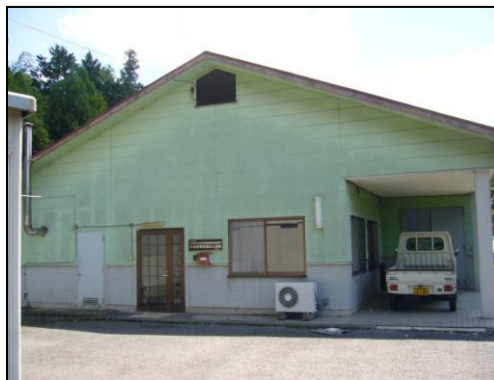
< 都祁農畜産物処理加工施設 >
