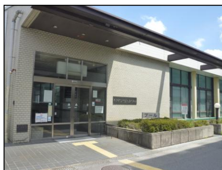
<屋内温水プール>
