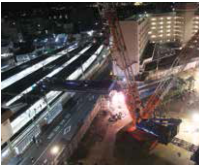
2月28日に行ったクレーンで橋脚の上に通路の床部分を釣り上げて設置する「桁仮設工事」
