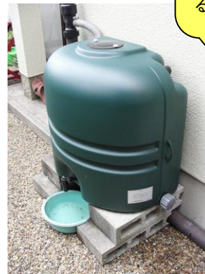
うすい 雨水タンク
