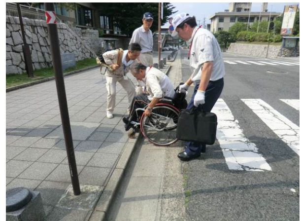
※段差があり、車いすで通行しにくい
