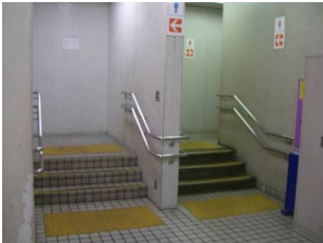
○トイレ前に段差がある、視覚障害者誘導用ブロックが連続していない、多機能トイレがない
