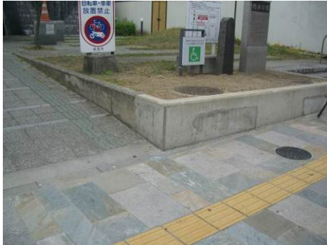
○視覚障害者誘導用ブロックが前面歩道と連続していない。
