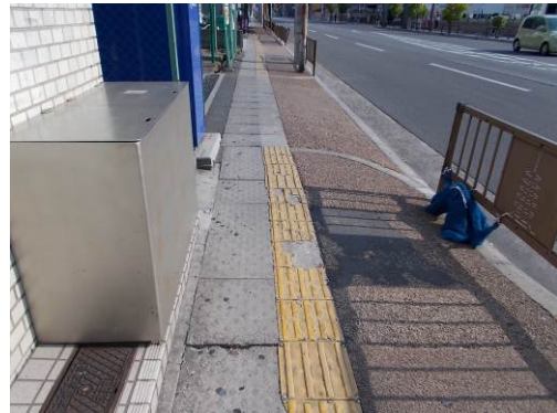
○視覚障害者誘導用ブロックの破損・不連続
