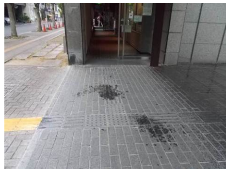
○視覚障害者誘導用ブロックが床面と同系色となり弱視の方には判別できない
