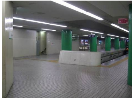
○視覚障害者誘導用ブロックがエレベーターまで連続していない
