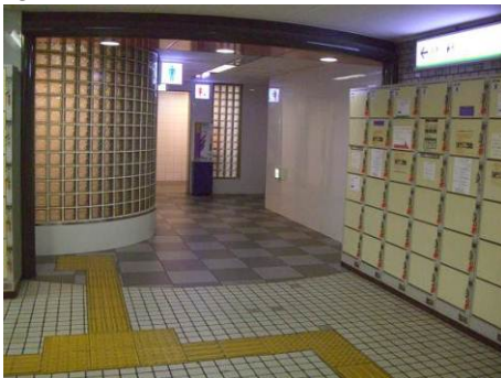
○視覚障害者誘導用ブロックがトイレの入り口まで設置されていない
