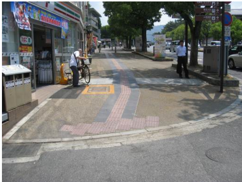
○視覚障害者誘導用ブロックの明度差が小さく視認性が低い、視覚障害者誘導用ブロックの配置が不適切
