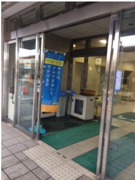
北棟（駐車場側）出入口
