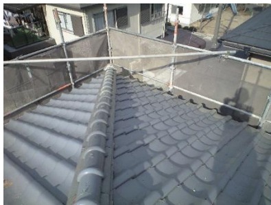
工事前：土葺き瓦撤去
