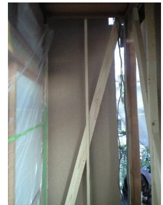
耐力壁不足のため、筋かいにより補強
