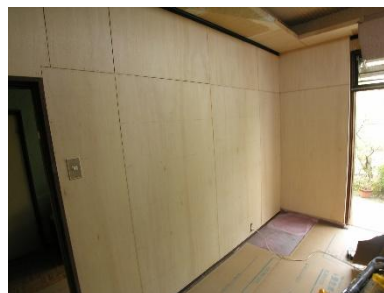
耐力壁不足のため、既存壁を外し合板にて補強
