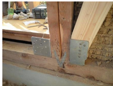
柱と土台の接合が不十分であったため新たに金物を取り付けし補強
