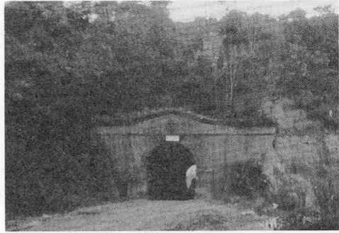
大仏鉄道黒髪山（北側）トンネル
