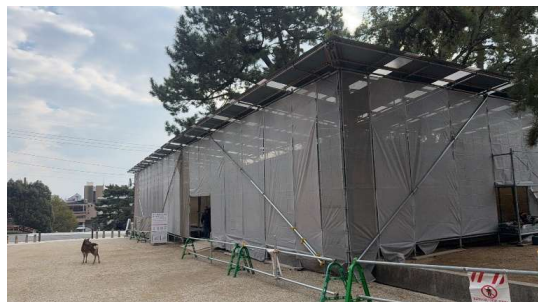
●東側築地修理工事 令和8年2月12日撮影
