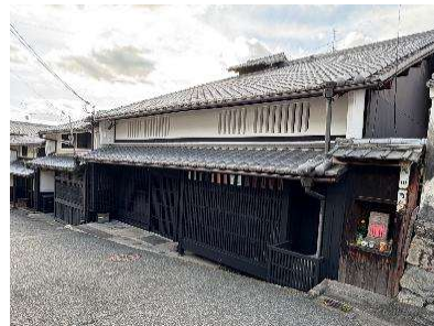
【修理後】 令和7年12月10日撮影
