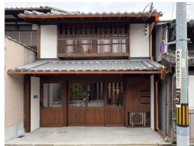
【修理後】 令和8年2月10日撮影
