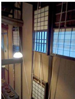
土間の天窓の開閉実演 令和7年11月2日撮影
