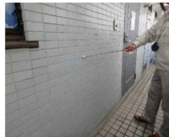
「外部（外壁）」調査の様子
