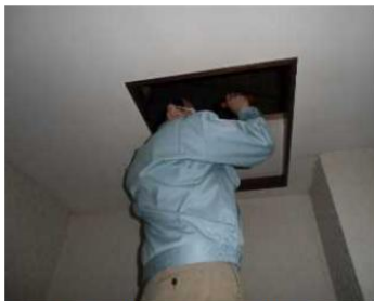
「小屋組・梁」調査の様子
