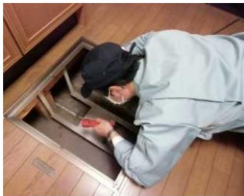
「土台・床組、基礎」調査の様子
