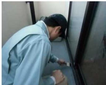
「外部（バルコニー）」調査の様子
