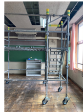
▲天井板を外してグラスウールを載せる
