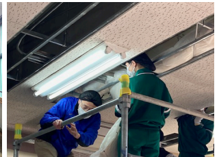
▲天井板を外してグラスウールを載せる
