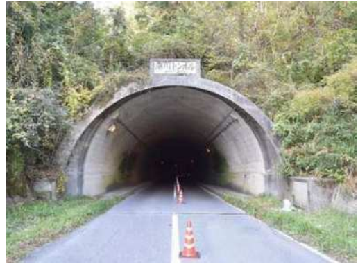
写真 2-5 深川トンネル
