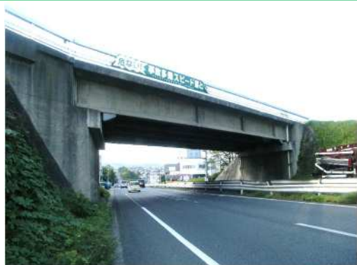
無名橋（登美ヶ丘中町線） ＜阪奈道路に架設＞
