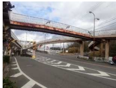
写真 2-4 鶴舞橋歩道橋
