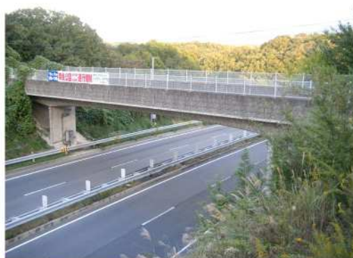
1号跨道橋（西部第731号線） ＜第二阪奈道路に架設＞
