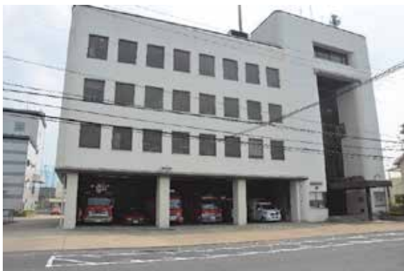
▲奈良市消防局 南消防署
