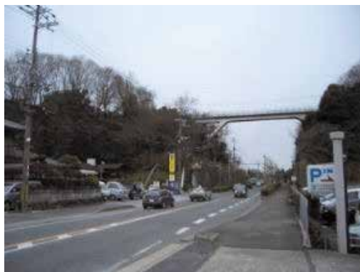
▲黒髪山トンネルのあったところ
