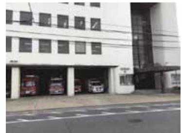
▲奈良市消防局南消防署
