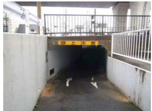
写真 2-6 中部第 736 号線トンネル
