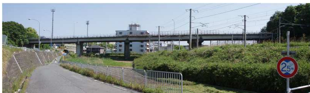
平城大橋(奈良阪南田原線) <国道24号・JRに架設>
