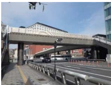
写真 2-3 三条宮前歩道橋
