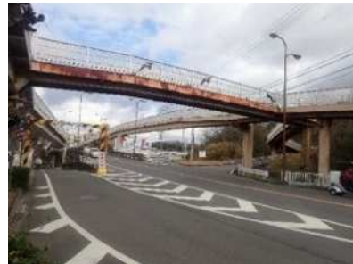
写真 2-4 鶴舞橋歩道橋
