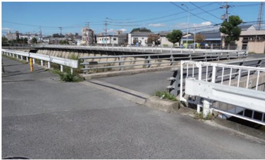
転落防護柵設置箇所(右)と未設置箇所(左)
