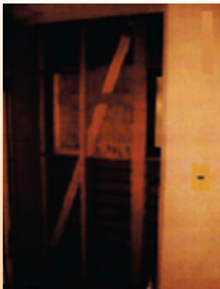
開口部を閉めて耐力壁を設置しました。
