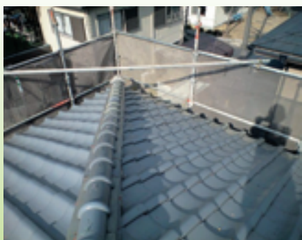
(工事前) 土葺き瓦を撤去
