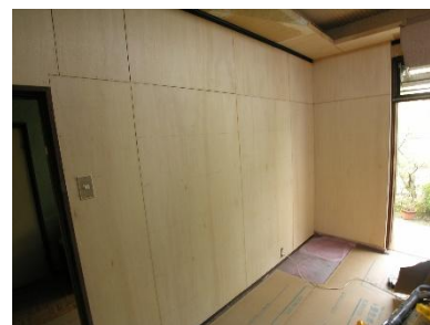
耐力壁不足のため、既存壁を外し合板にて補強
