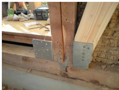
柱と土台の接合が不十分であったため新たに金物を取り付けし補強
