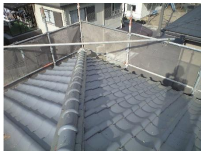
工事前：土葺き瓦撤去
