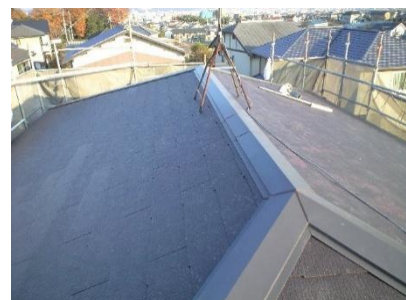
軽い屋根に葺き替えし、建物重量を軽くし建物全体の耐震性能向上
