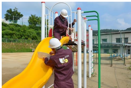
■事例-公園施設の定期的な点検 (一般社団法人日本公園施設業協会 HP)
