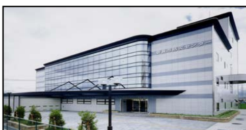
防災センター
