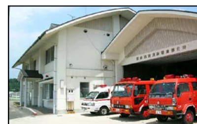
東消防署東部分署
