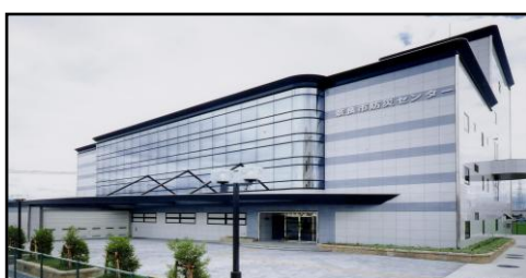
防災センター
