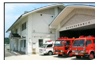
東消防署東部分署
