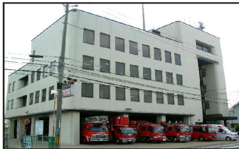
消防局・南消防署併設庁舎
