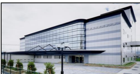
防災センター
