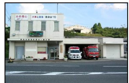
東消防署月ヶ瀬分署
