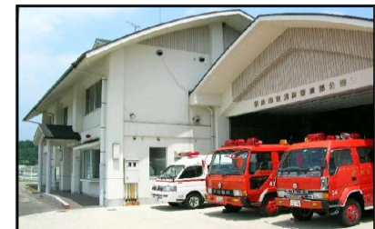
東消防署東部分署
