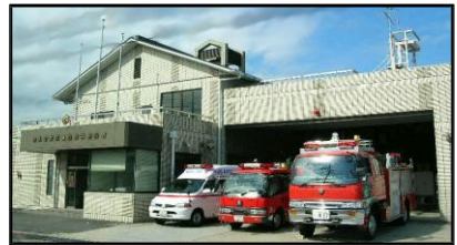
中央消防署南部分署
