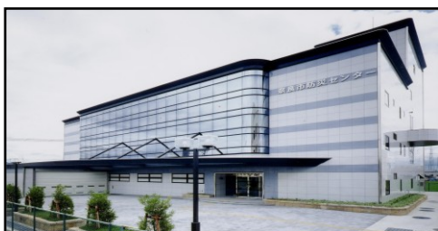
防災センター
