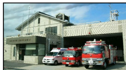
中央消防署南部分署
