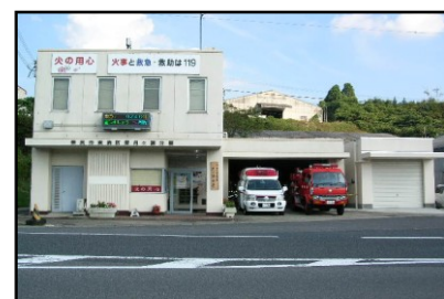
東消防署月ヶ瀬分署
