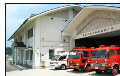
東消防署東部分署
