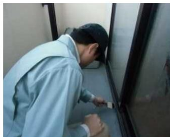
「外部（バルコニー）」調査の様子
