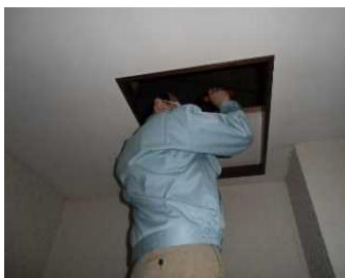
「小屋組・梁」調査の様子
