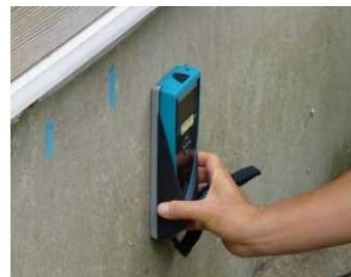
「基礎配筋」の調査機器
