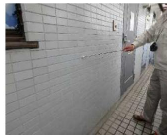
「外部（外壁）」調査の様子
