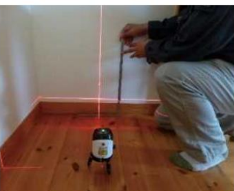
「床の傾きを計測する」調査機器
