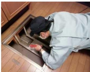
「土台・床組、基礎」調査の様子
