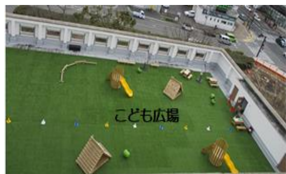
東棟屋上南側（こども広場）
