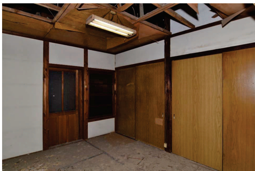
帯解駅本屋 17 休憩室
