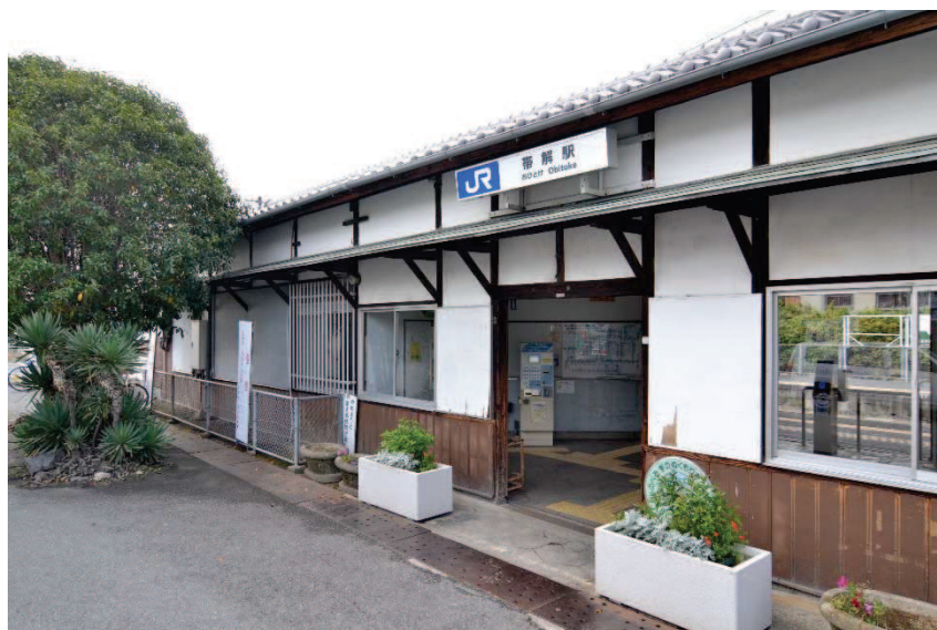
帯解駅本屋 05 正面詳細
