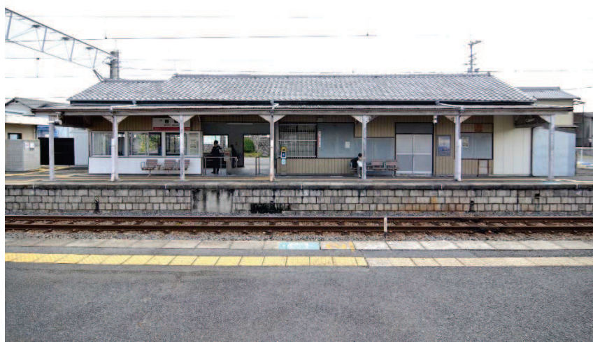
帯解駅本屋 08 西面
