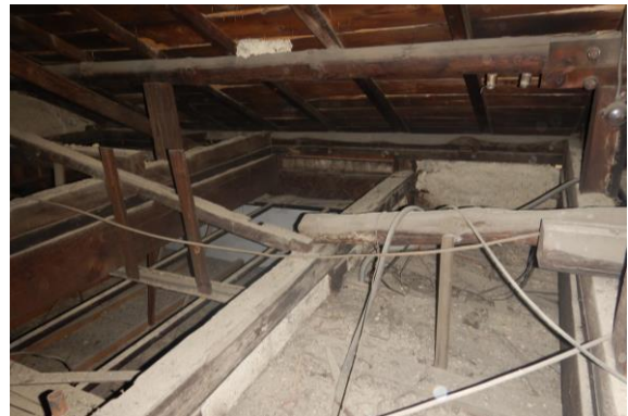
天井裏の状況
